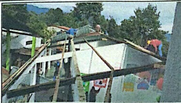
Foto 2: Desmontaje de lamina y tendales de madera a sustituir.
