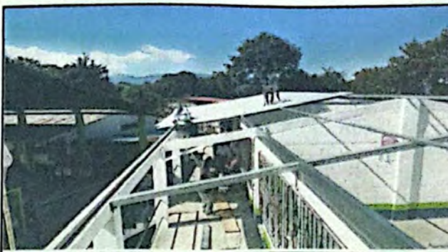
Foto 4: Instalacion de Lamina al modulo con estructura metalica.
