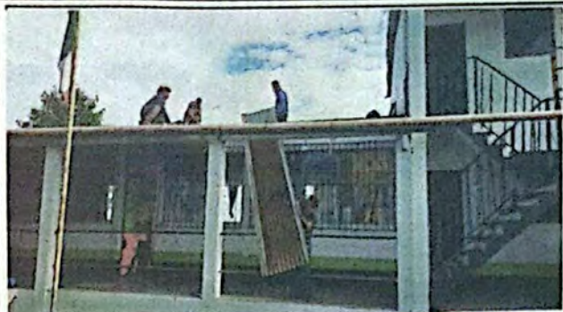
Foto 1: Desmontaje de lamina del modulo a sustituir.
